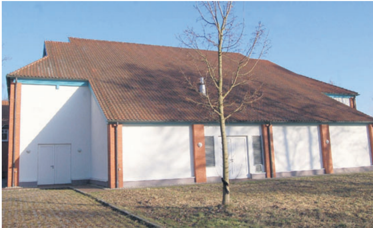
Die Dachfläche ist groß auf der Beeke-Sporthalle in Otterstedt und eignet sich damit hervorragend für die Installation einer großen Photovoltaikanlage. Gesellschafter für die Bürgersolaranlage werden noch gesucht. FOTO: UWE DAMMANN
